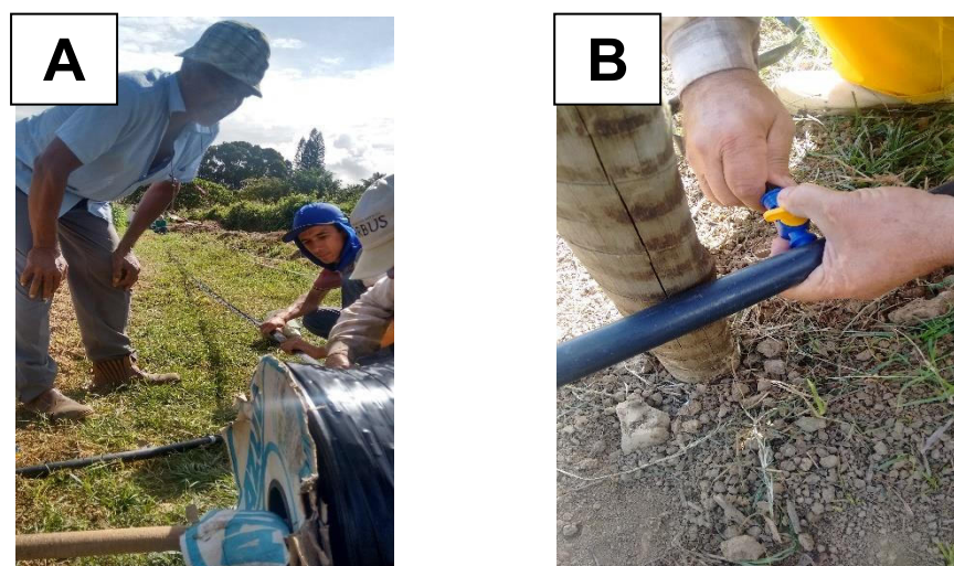
Figura 147: Montagem do sistema de irrigação. (A) Corte da fita gotejadora. (B) Acoplamento da linha lateral na linha de distribuição. Fotos: Daniel Conde, 2017.
