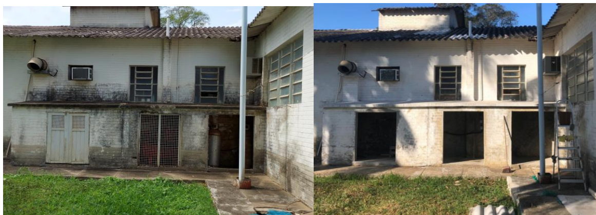
Reformas da casa de gás acontecendo no Centro de Análises. Antes (esquerda), Depois (direita).
